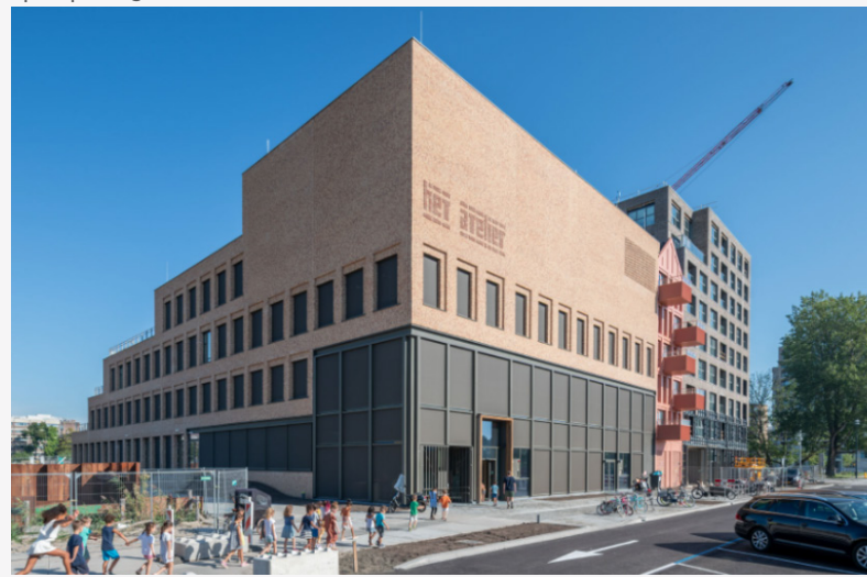
Schoolgebouw 't Atelier met achter de bakstenen gevel de sporthal
